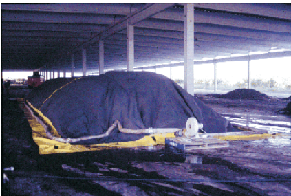
● Coberta de làmina geotèxtil.
